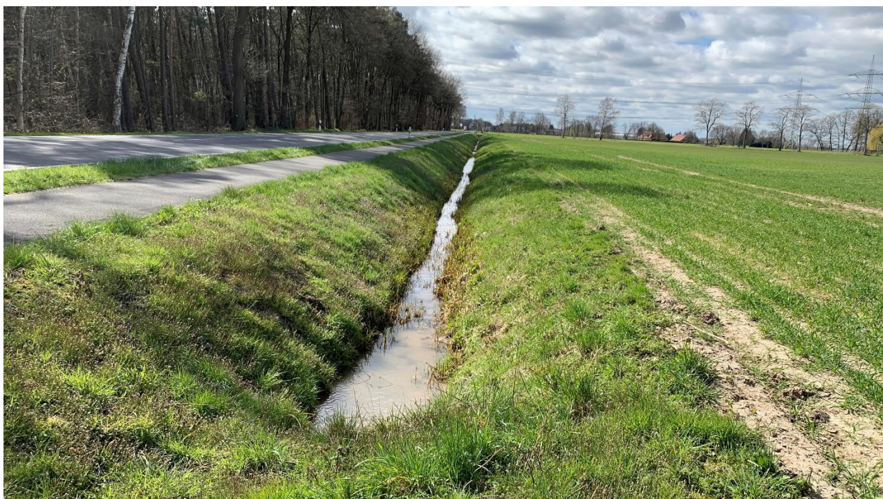
Abb. 13: Graben zur Aufnahme und Ableitung der Filtrerrückspülwässer des Wasserwerkes Mundersum (Foto: BGU 01.04.2020, 52,28.42N / 7,23.43E)
