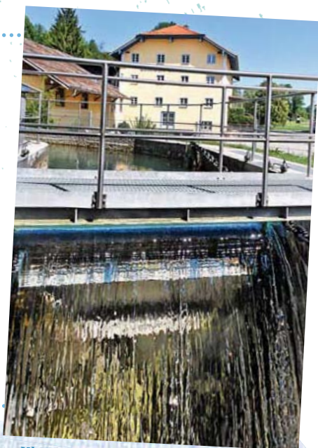
Kleines Wasserkraftwerk am Fluss
