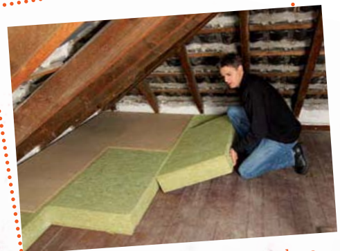
Wärmedämmung des Dachbodens
