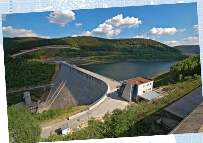
Talsperre im Mittelgebirge in Thüringen
