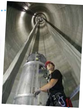
Im Turm einer Windenergieanlage
